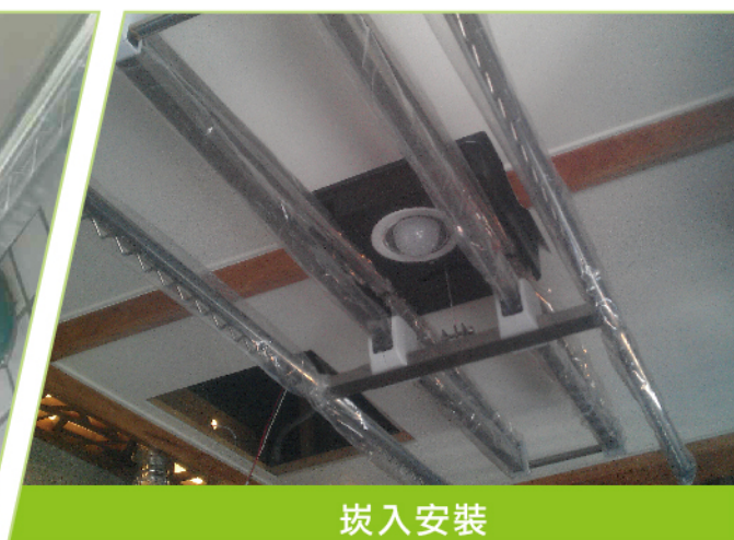
C型鋼安裝(適用於鐵皮屋)
